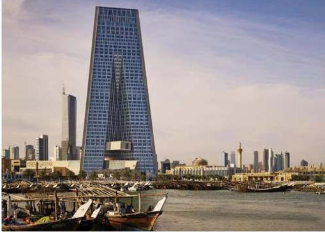
مشروع البنك المركزي الجديد Central Bank of Kuwait
