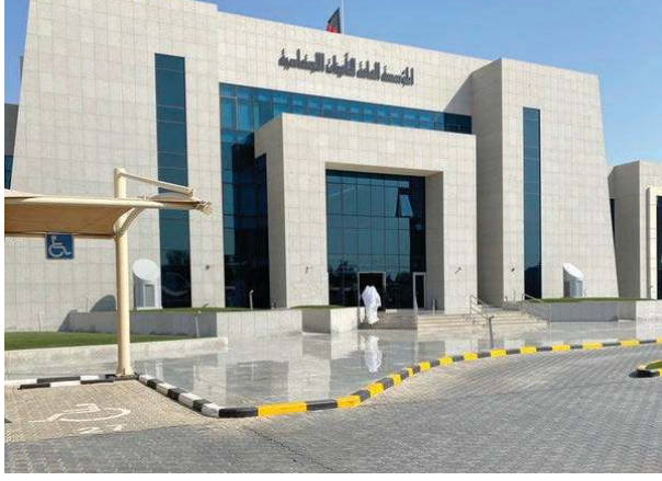
مشروع مبني التأمينات الاجتماعية Social Security Building Project
